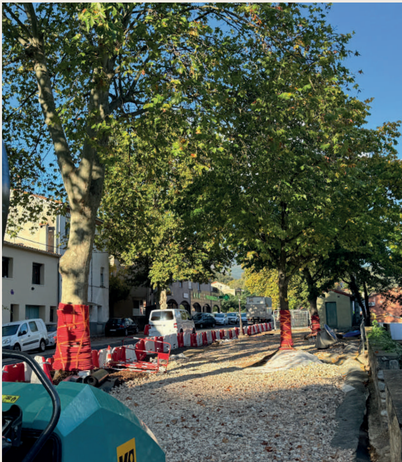
Travaux de voirie et création d'une plateforme à Reynès.
